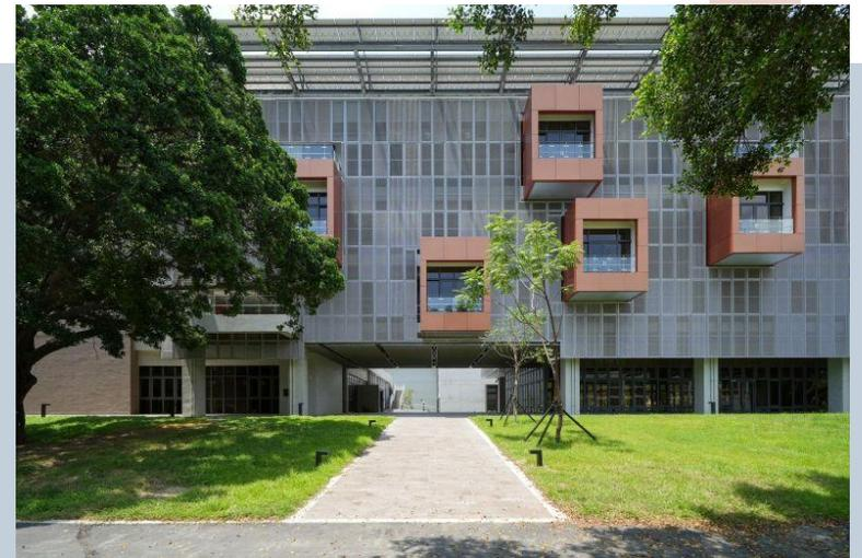
地下一層，地上四層鋼筋混凝土+鋼骨建築物，建築面積為20339.72m<sup>2</sup>，總樓地板面積為9835.36m<sup>2</sup>。
